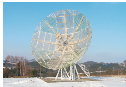
Parabolická anténa pro pásmo 1,5 GHz, \varnothing 10 m ( www.anteny-proch.ignum.cz )
